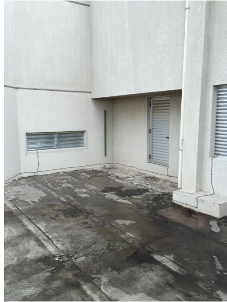
Aterramento realizado pelo Condomínio – cobertura bloco A
