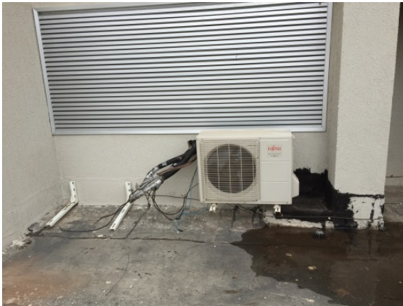
Instalação de ar condicionado na cobertura bloco B
