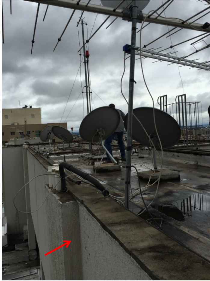
Fixação original da antena coletiva
