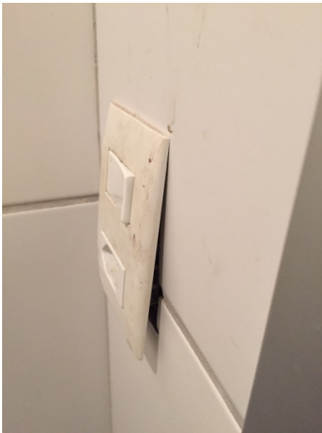
Lixeira 19º andar bloco A
