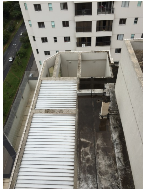
Fechamento da cobertura realizado pelo proprietário – bloco A
