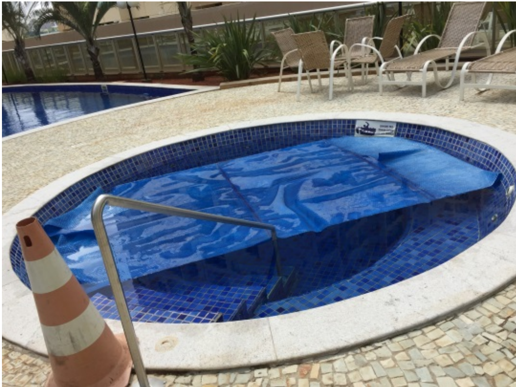
Proteção para evitar perda de calor do spa aquecido
